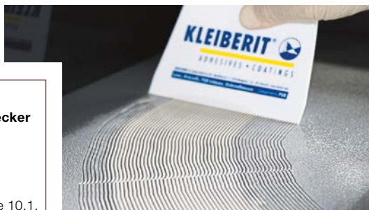
Der STP-Klebstoff »Kleiberit 605.1« lässt sich wie üblich mit dem Spachtel auftragen
